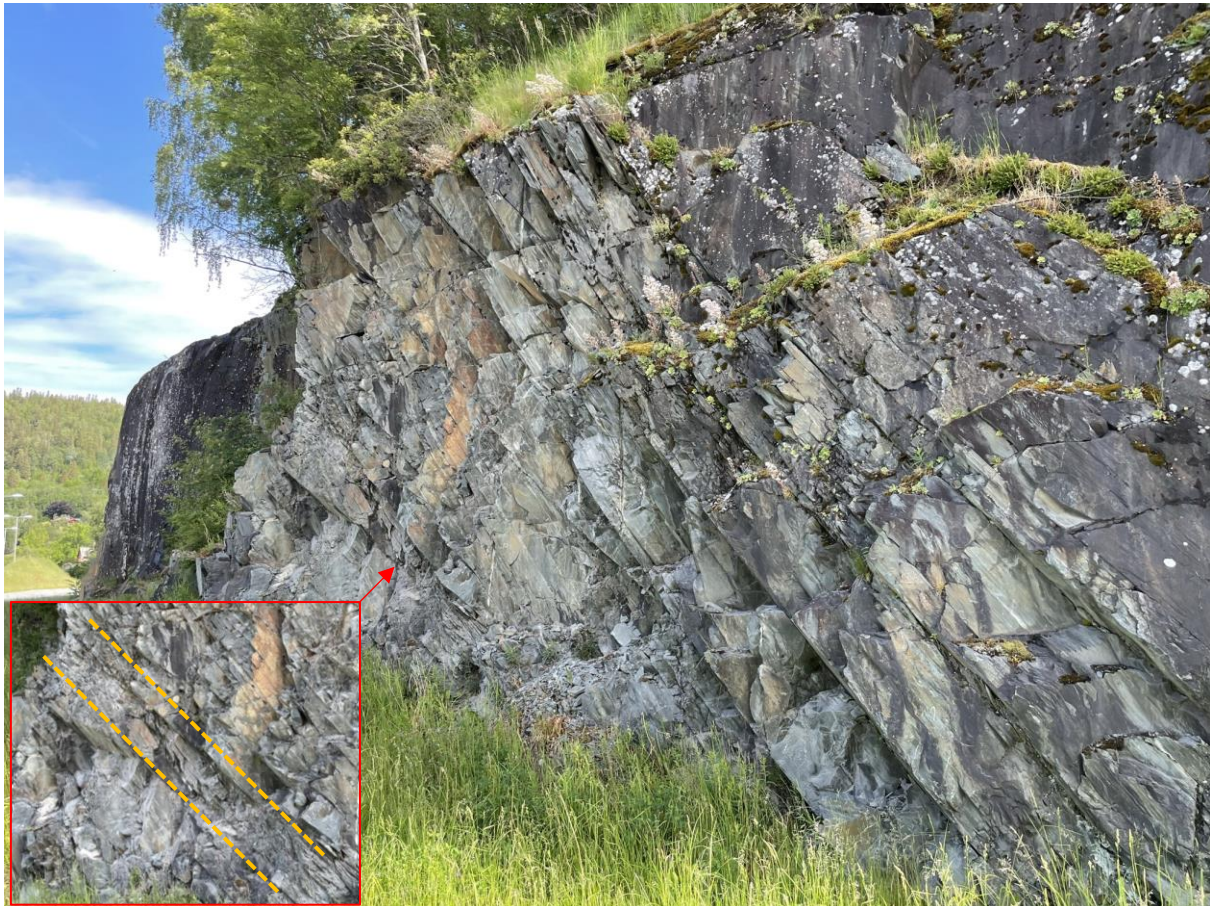
Figur 2-6: Viser parti i sørlige ende av dagens bergskjæring med en lagpakke bestående av tettere oppsprukket og skifrig bergmasse. Bredde på «sonen» er ca. 5 m. Utfelt bilde nede i venstre hjørne viser område med tettest oppsprekking. Sonen følger i hovedsak sprekkesett S1 og har fallvinkel ca. 50° inn i eksisterende skjæring. (Kilde: Norconsult)
